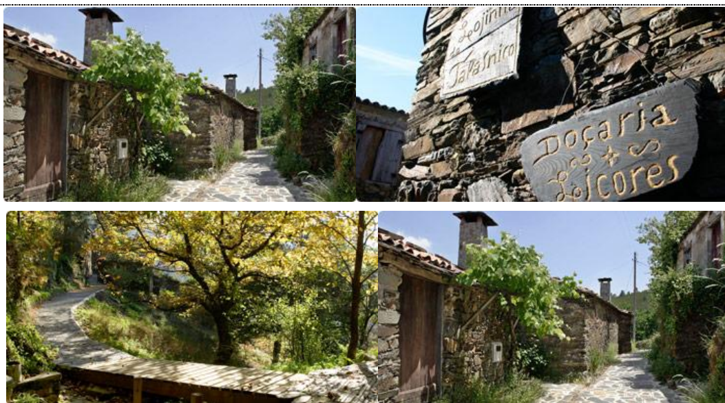
Figura 17. Aldeias de Xisto da Lousã. No sentido dos ponteiros do relógio: Casal Novo, Talasnal, Chiqueiro e Cerdeira.
