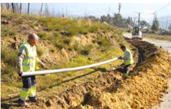
INSTALAÇÃO DE INFRAESTRUTURAS DE ÁGUAS EM SERPINS
