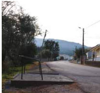
CONSTRUÇÃO DE BASES DE CONTENTORES
