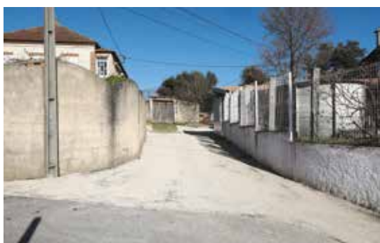
PAVIMENTAÇÃO RUA DA GÂNDARA SERPINS
