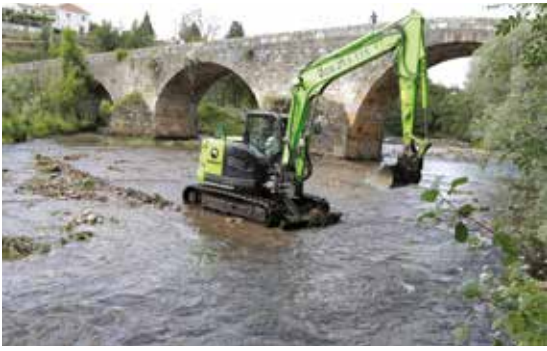
REGULARIZAÇÃO DO LEITO DO RIO CEIRA
