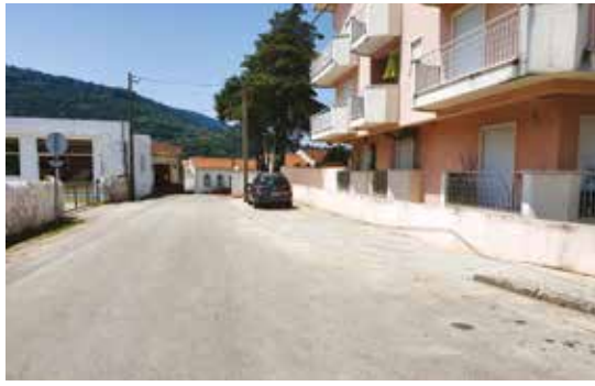
PAVIMENTAÇÃO EM CASAL DOS RIOS
