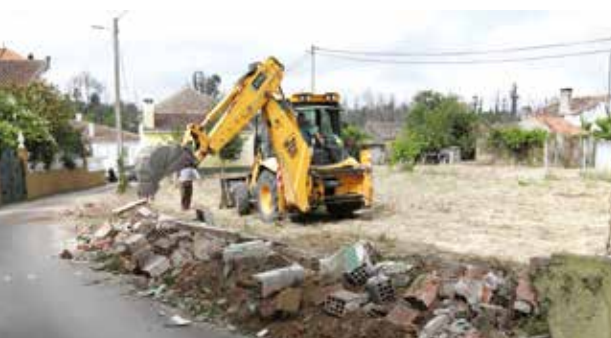
ALARGAMENTO DE VIA PRILHÃO
