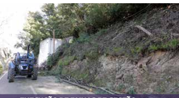
EXECUÇÃO DE FAIXAS DE GESTÃO DE COMBUSTÍVEL EM DIVERSAS VIAS
