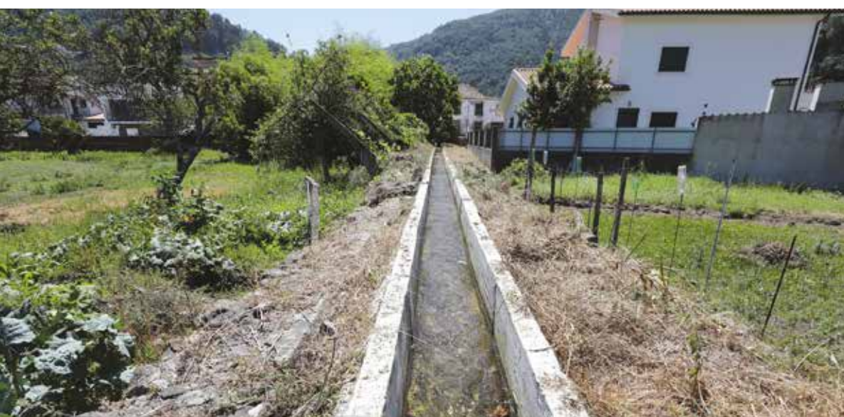
RECUPERAÇÃO DO REGADIO DA RIBEIRA DE SÃO JOÃO
