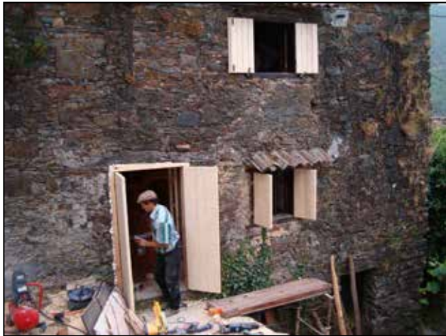
Fotografia 25 – Casa em obras no Talasnal (2003)
