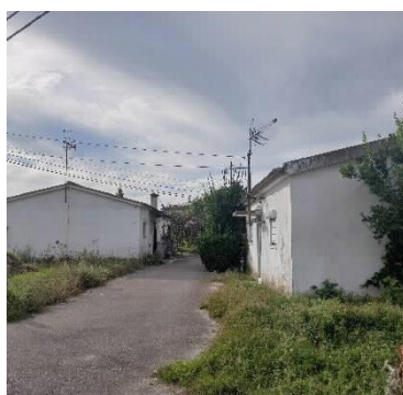
Figura 2 - Alojamentos de habitação social com necessidade de reabilitação
